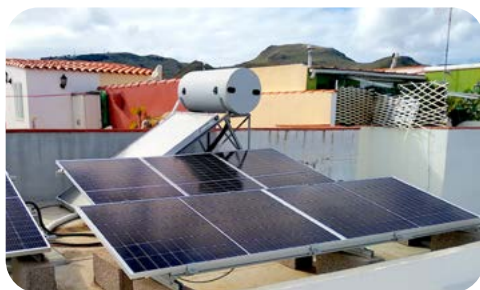
Imagen 7. Termosolar para agua sanitaria y fotovoltaica - Ruth Acosta / ADACIS
